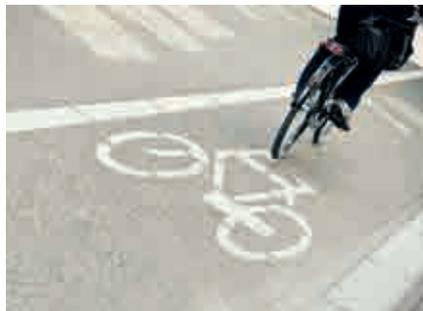
Schutzstreifen sind keine Sonderwege für Radfahrer und werden daher nicht mit Zeichen 237 gekennzeichnet, sie sind Teil der Fahrbahn. Sie können angelegt werden, wenn dem Radverkehr ein besonderer Schonraum angeboten werden soll und Fahrbahnbreite sowie Verkehrsstruktur es grundsätzlich zulassen.
